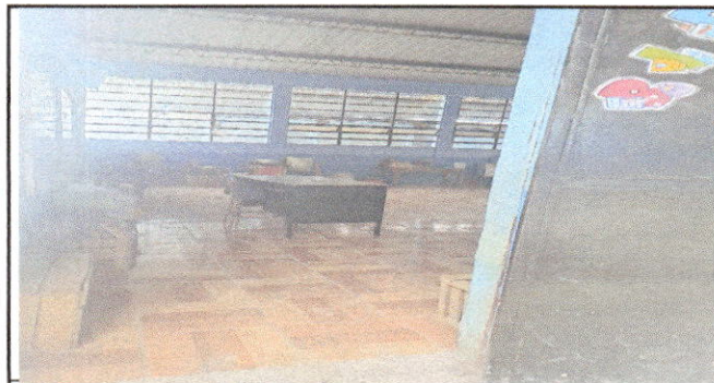
Foto 5: piso del aula 5 Primero B, con piso cerámico completo.
