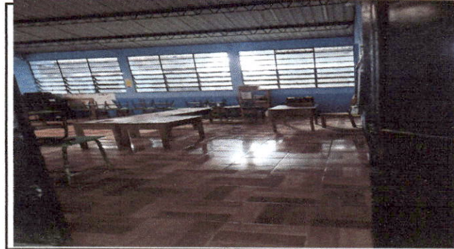
Foto 4: piso del Aula 4 Segundo C, ya con el piso cerámico colocado.
