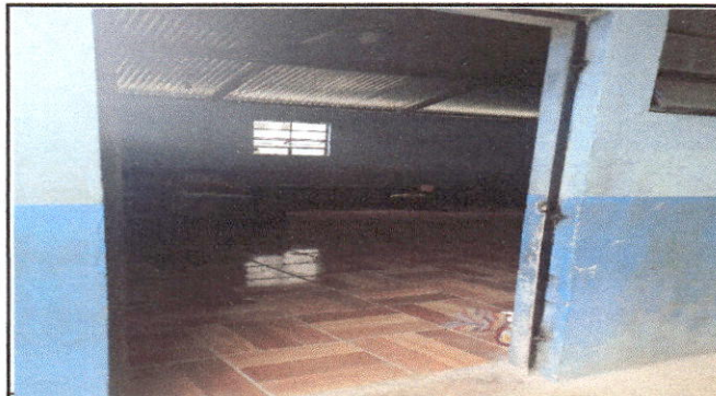
Foto 3: Piso del aula 3 Segundo B se colocó el piso cerámico por completo.
