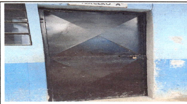
Foto 10: la puerta con marco seguro y de concreto, ya se puede abrir y cerrar correctamente sin problema que se caiga.
